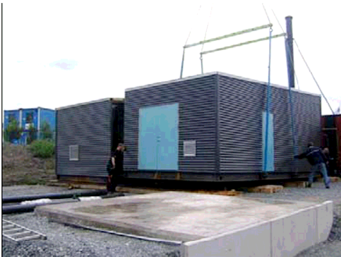
Figur 8 Montering av prefabrikkert biokjele (kilde: Justsen)
