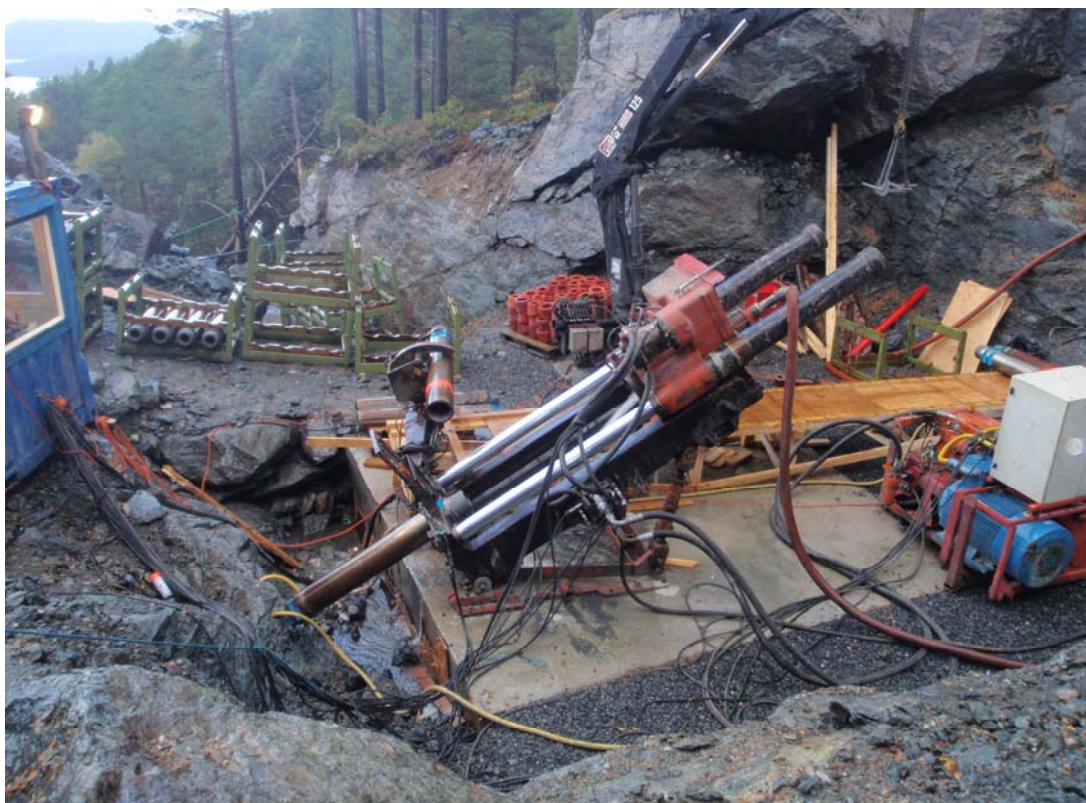
Fig 17: Bilde som syner rigg for profilboring. Frå bygginga av Hovland kraftverk, Eikefjord.
