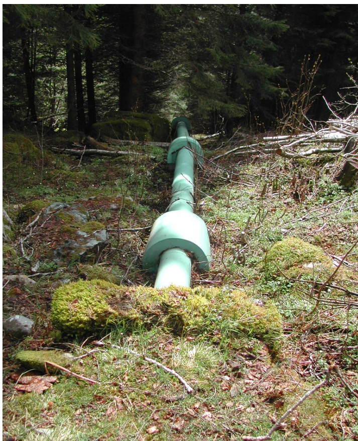
Fig 15: Bilde som syner framføring av rørgate i dagen i bratt terreng.
