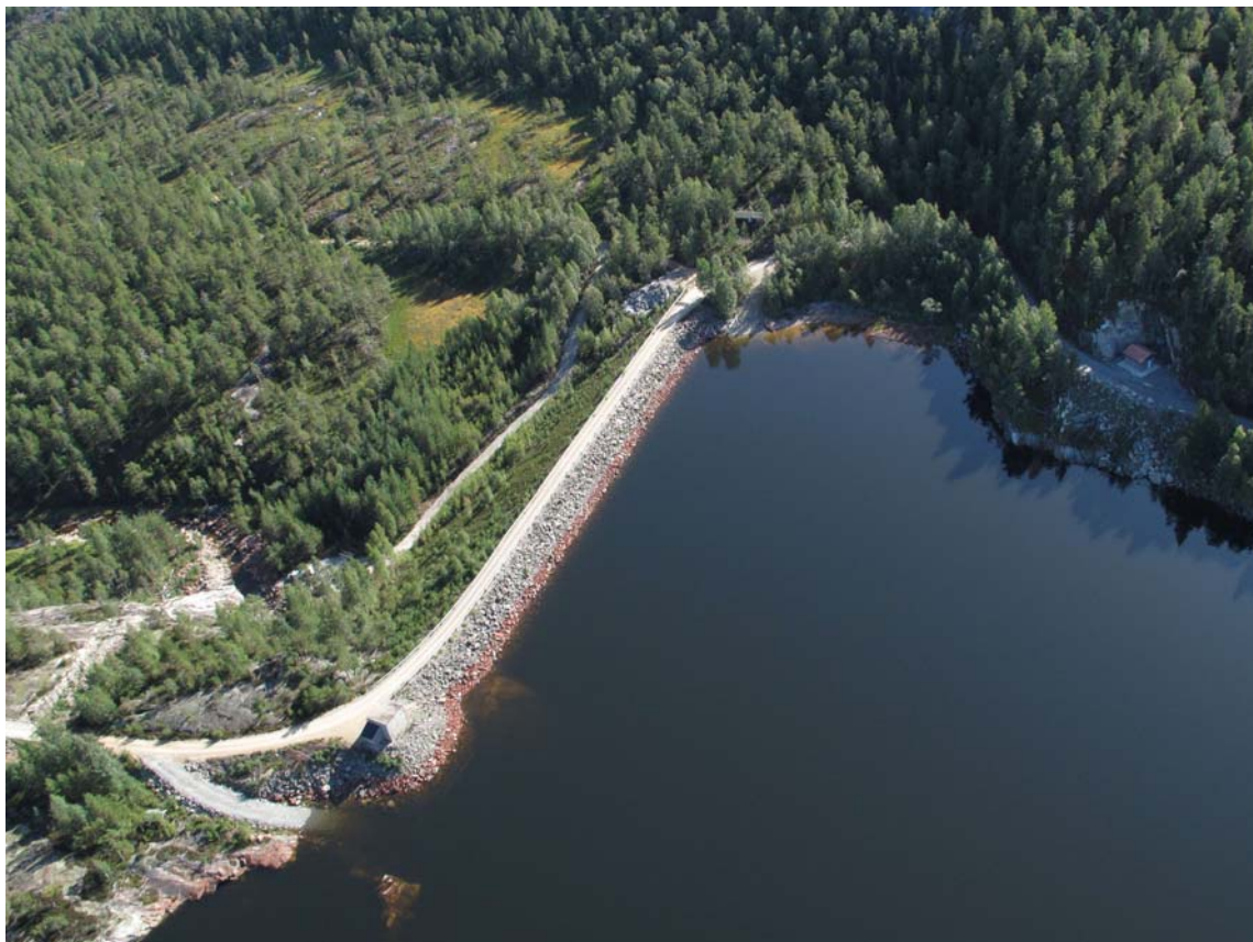
Figur 13. Inntak til Vassfossen Kraftverk ved Eptevannsdammen. Lukehuset til høyre i bildet er inntaket til kraftverket.
