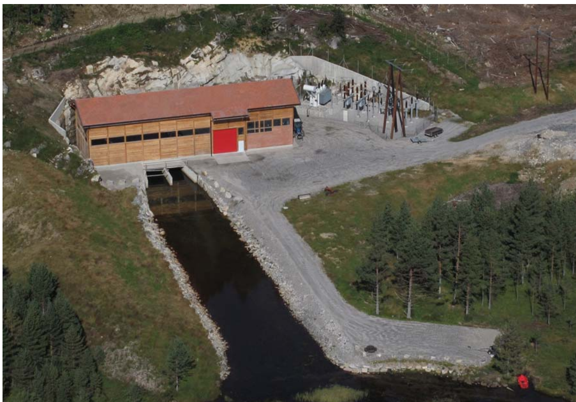
Figur 14. Vassfossen Kraftverk. Utløp med åpen kanal ut til Vassvann.
