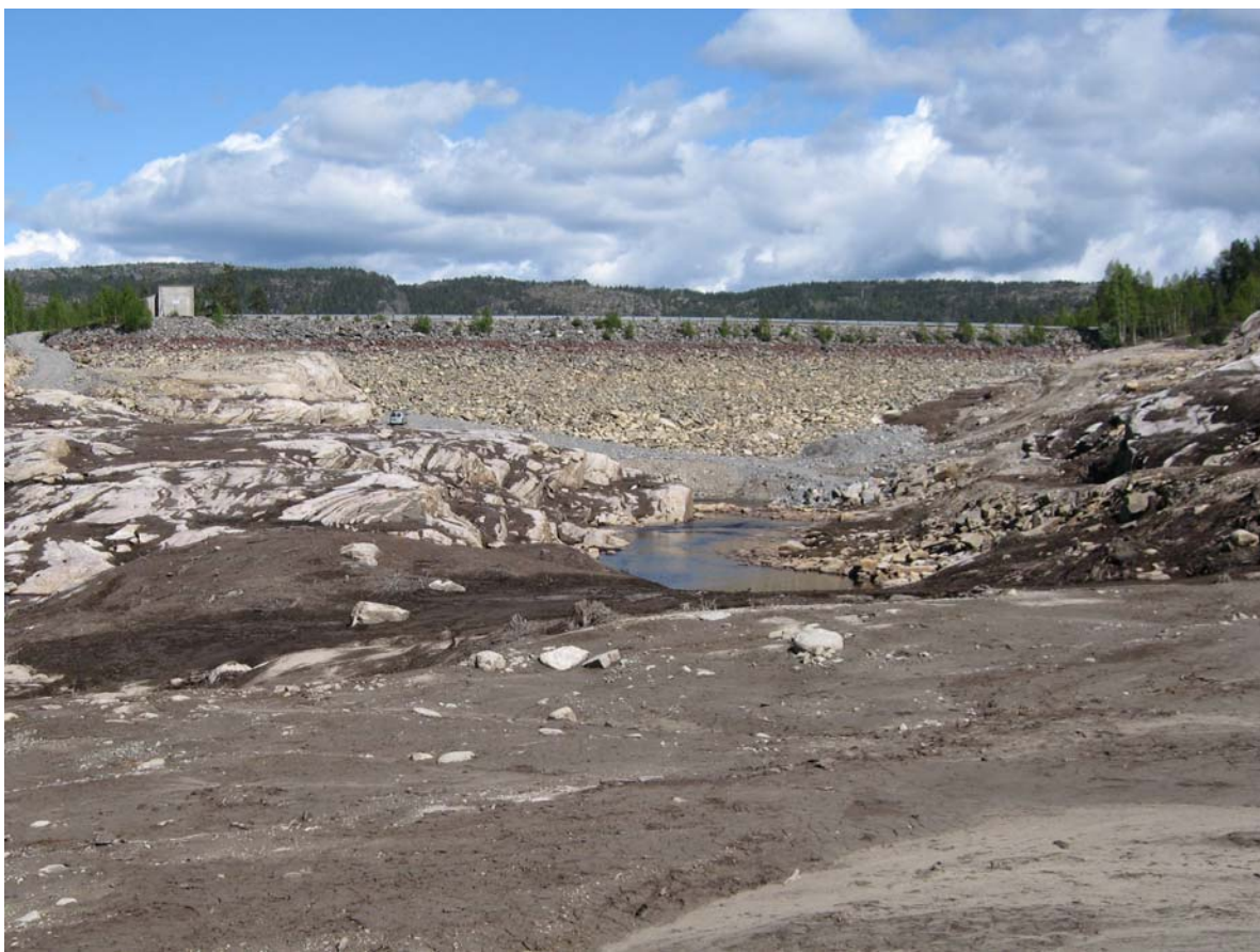
24. Eptevannsdammen ved nedtappet magasin. Fotografert fra innsiden av magasinet som normalt er under vann. Bilde tatt 09.05.2007.
