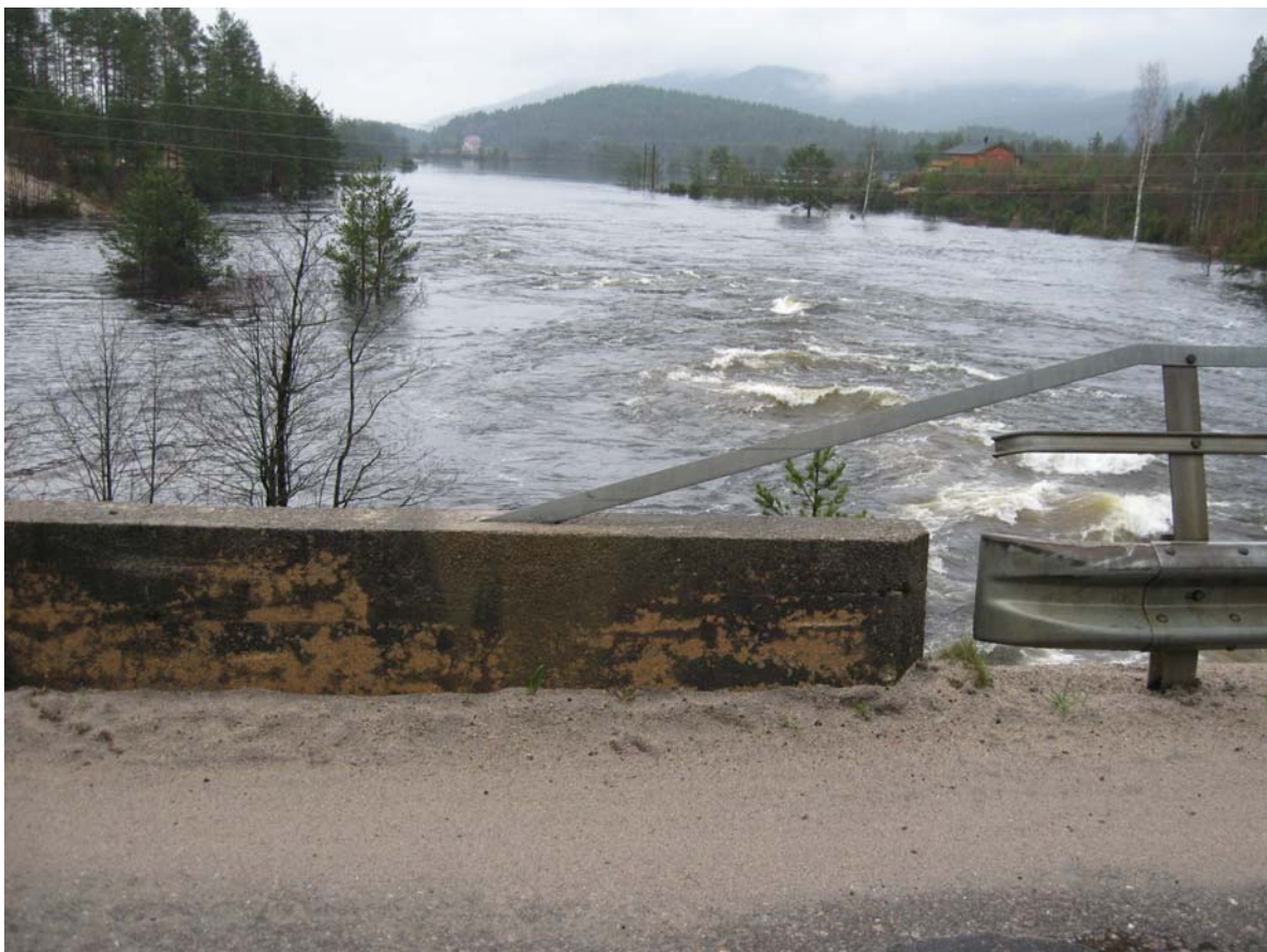
18. Skjeggedalskrysset sett ned mot Steane. Flomvannføring. Bilde tatt 01.05.2008.
