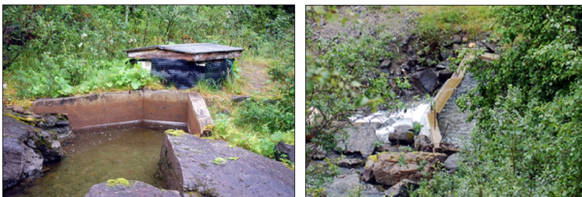
Figur 14. De to private overflatevann-inntakene i Storelva (til venstre) og i Ystelielva (til høyre).
