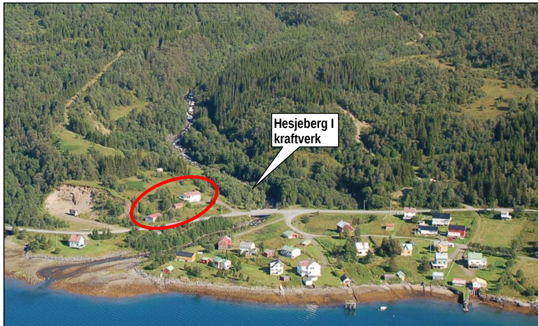
Figur 28 Ved et delvis rørbrudd nede ved Hesjeberg I kraftverk, kan 2 boligenheter og fylkesveien berøres.
