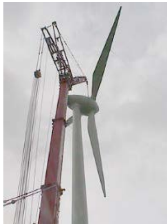
Figur 7: Eksempel på montering av turbin ved hjelp av spesialkran
