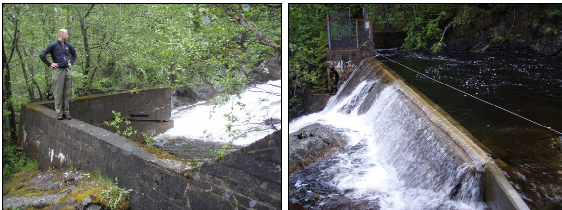
Figur 3 Til venstre: Gammel grunnmur ved planlagt kraftstasjon. Til høyre: Gammelt vannverksinntak.
