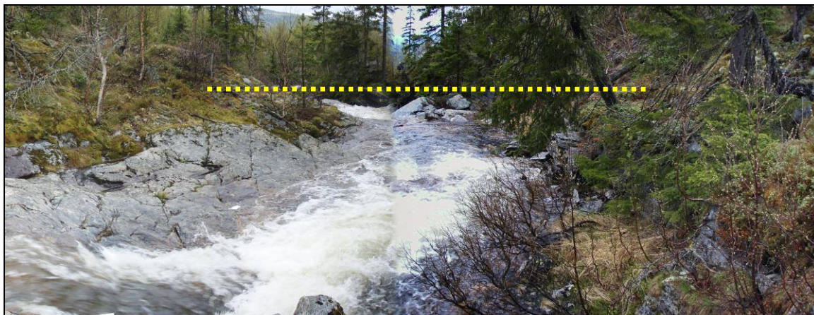
Figur 7 I Årekleppåi bygges en enkel sperreteriskel for overføring av vann til inntaket i Reinsetåi.
