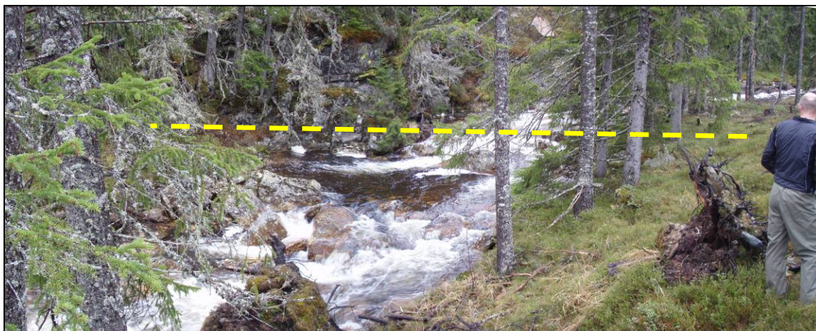
Figur 6 Planlagt inntak i Reinsetåi. Høyden på inntaksdammen illustrert.
