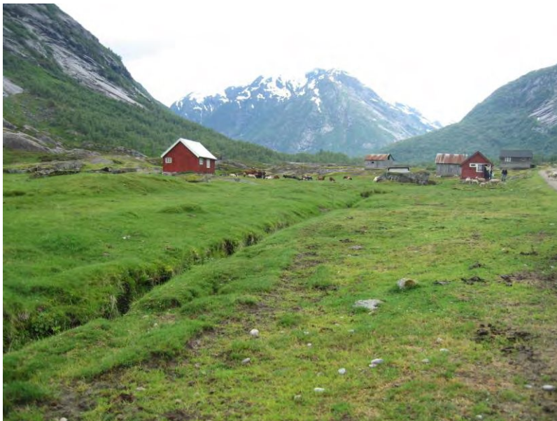
Figur 8 Den gamle kanalen til elvekraftverket kryssar naturbeitemarka på selbøen.
