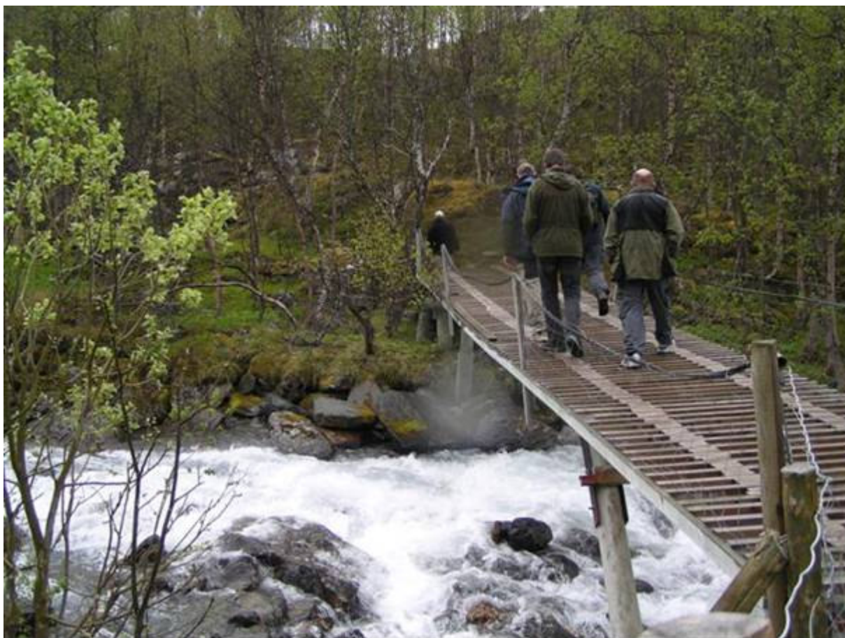
Figur 2.10 Bru over Kippeelva ved vanninntaket.
