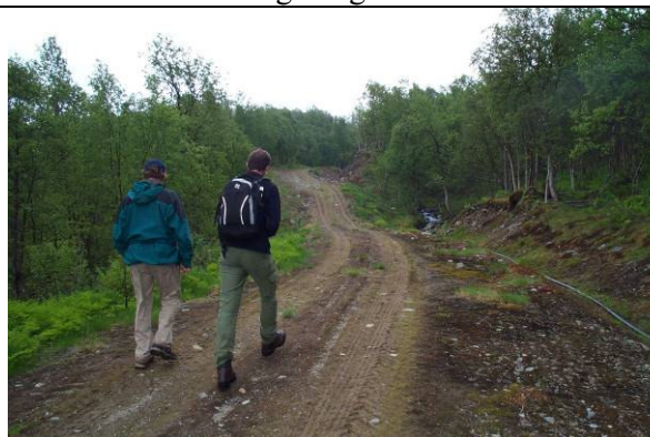
03 Rørtraséen blir lagt langs denne veien
