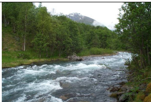
17 Elva ved kraftstasjonsutløpet
