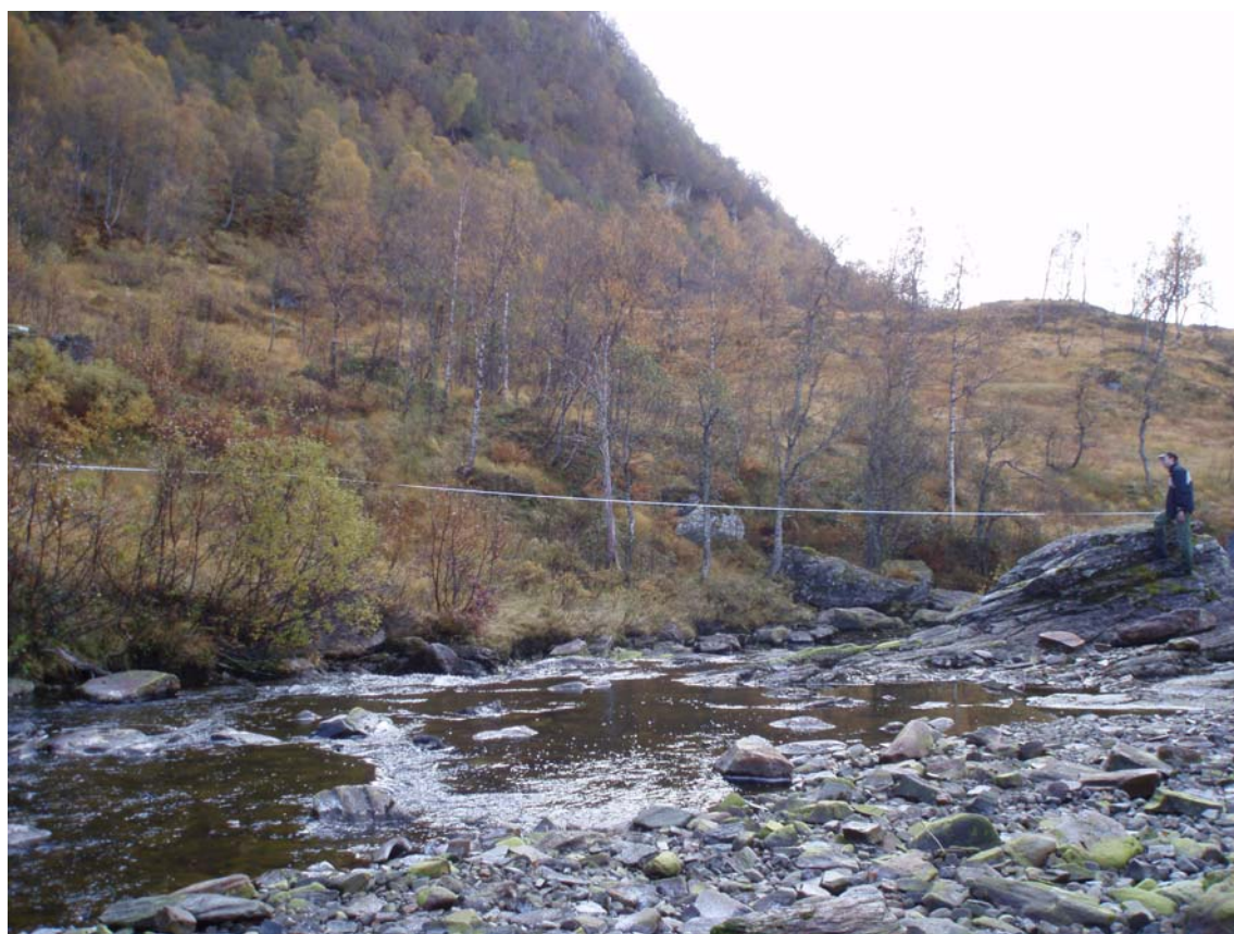
Foto 10 Inntaksdammen vil bli her. Bildet er tatt medstrøms. Inntakskonstruksjonen vil bli til høyre i bilde. Vannføring anslått til ca 600 l/s.
