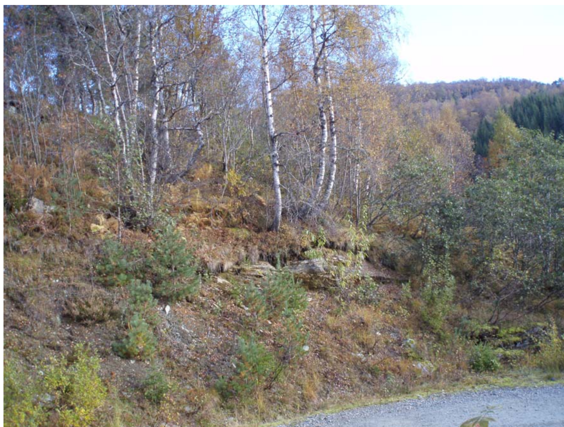
Foto 4 ca ved kote 425 gjør veien en sving, her fortsetter røret rett frem opp i skråningen.
