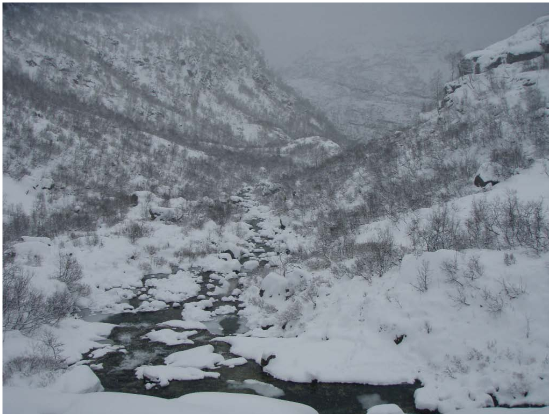
Bilde 2: 07.11.2007 ned mot inntak fra oppstrøms side – ca. 0,6 m 3 /s
