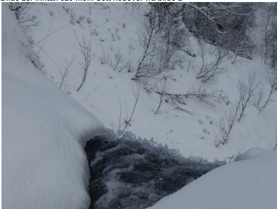
Bilde 23: Inntak 620 moh. Sett nedover fra bilde 1
