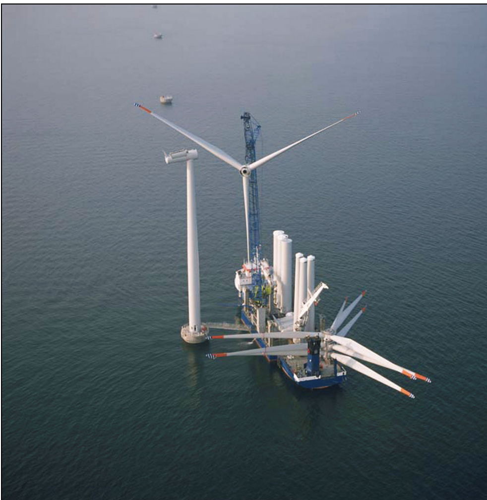
Figur 4.11 Illustrasjonsfoto - Montering av 2,3 MW vindmøller i Nysted Havmøllepark i Danmark
