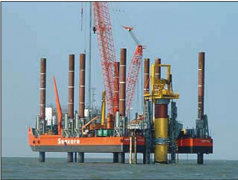
Figur 4.10 Spesialskip monterer vindturbiner. Lagringskapasitet på fire komplette turbiner ombord.
