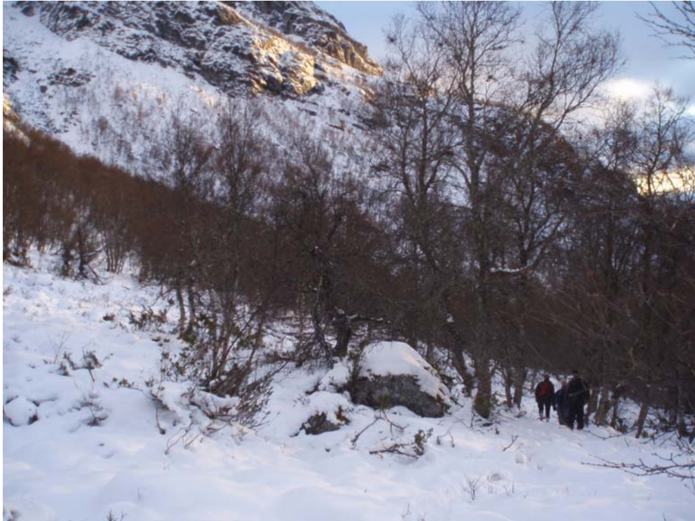
Foto 13 Her går overføringsrøret fra Naustelvi over til en kanal som fører vannet bort til inntaket i Grimsdalen.
