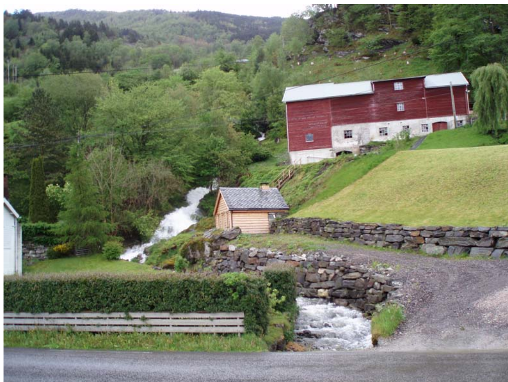
Foto 23 Nedre del av Børveelva ved kryssing under riksveien.
