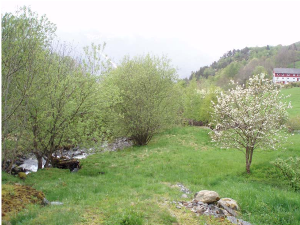
Foto 19 Fra Øvre Bøvre og nedover elven. Rørtrase på elvens høyre side.
