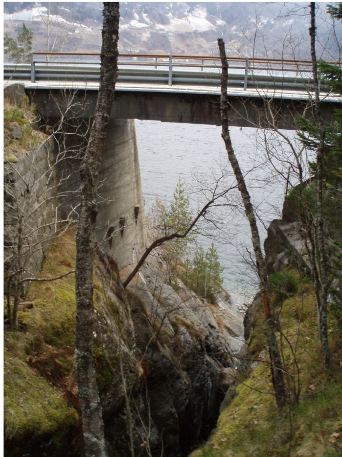
Foto 6 Byro ved utløpet i fjorden, med Rv 550 på bro over Byro. Gammelt brofundament sees til venstre i bildet.
