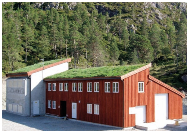
Figur 6.5 Transformatorstasjon og driftsbygg (eksempel fra Hitra vindpark)
