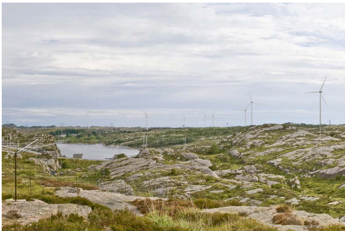
Figur 8 Kollsnes vindpark sett fra boliger på Øen nord for vindparken. Foto og visualisering: Einar Berg
