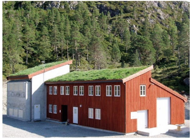
Figur 6.8 Transformatorstasjon og driftsbygg i Hitra vindpark
