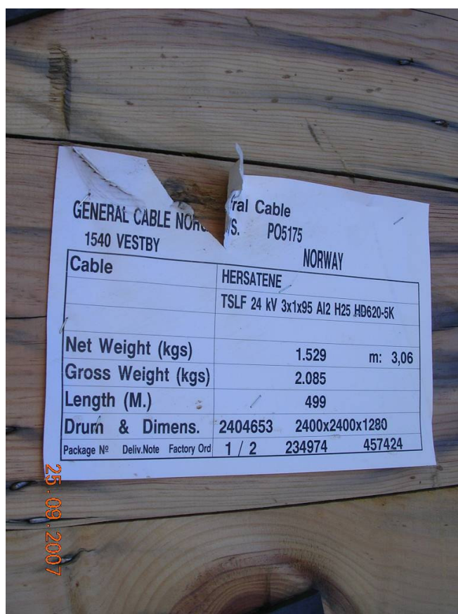
Figur 2.9 Fauske Lysverk AS la høsten 2007 ned 22 kV kabel til hyttefeltene.
