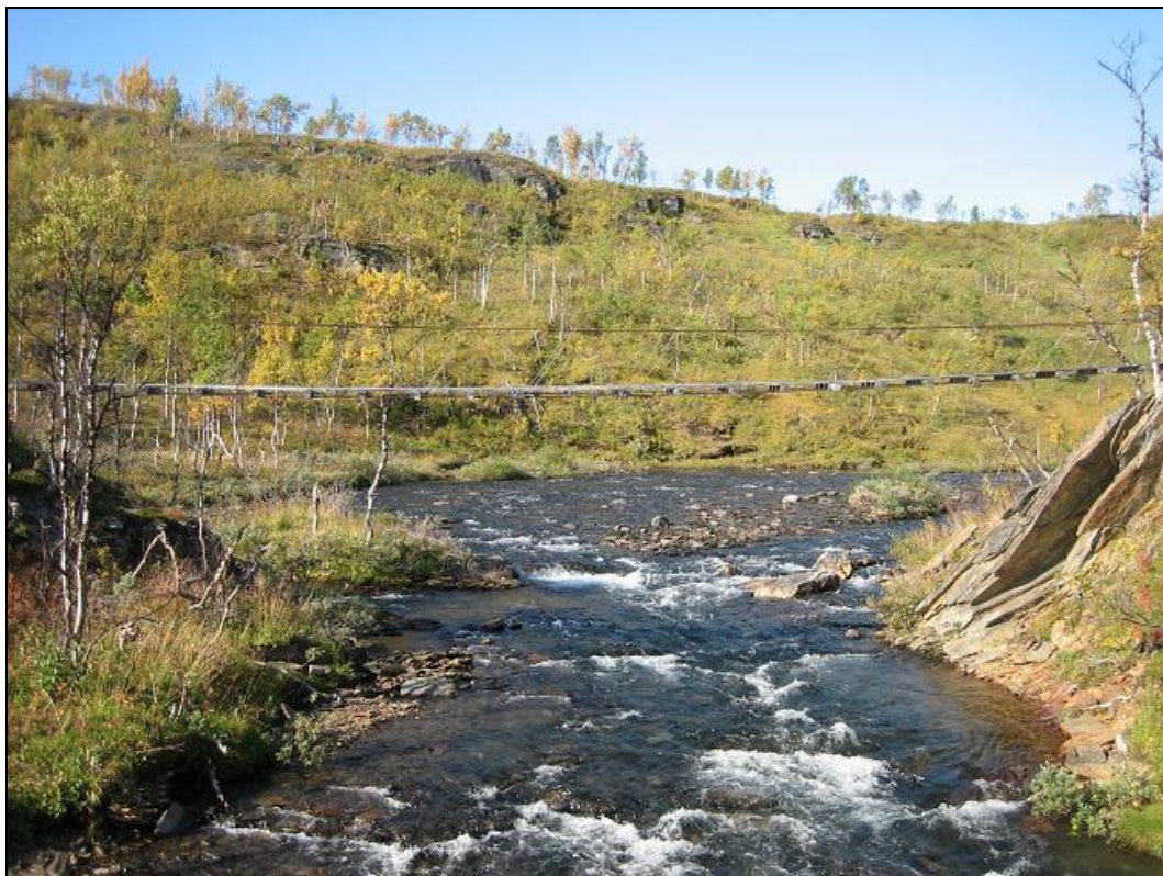
Foto 9: Bildet viser at stien som går fra Jakobsbakken i Sulitjelma og inn til Sverige krysser Beritelva med en hengebru like oppstrøms fossen i nedre del av influensområdet.
