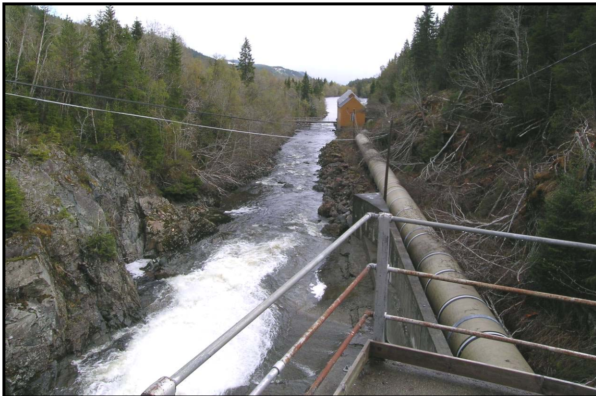
Bilde 4.3: Nedstrøms Gangåsvatn (inntaksdam til Sølbergfallet). Bygning på bildet er Sølbergfallet kraftverk, og i bakgrunn ser en noe av inntaksdammen til Skjenaldfossen.
