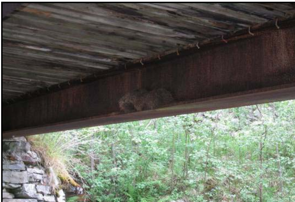
Bilde 4.9: Fossekalldreir på en bærebjelke under den gamle brua ved Kjellarenget. Denne hekkeplassen er benyttet i minst to sesonger (nytt dreir er bygd ved siden av det gamle).
