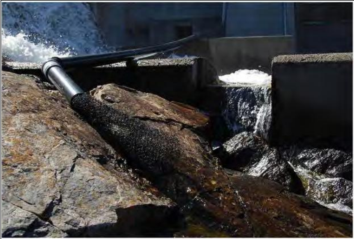
Figur 24 Forslag til åleledere, men til forskjell fra bilde vil alelederene gå ned i vannet.
