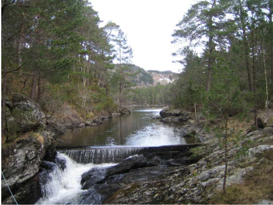
Bilde 7. Inntaksdam ved Vetlavannet sett mot nord
