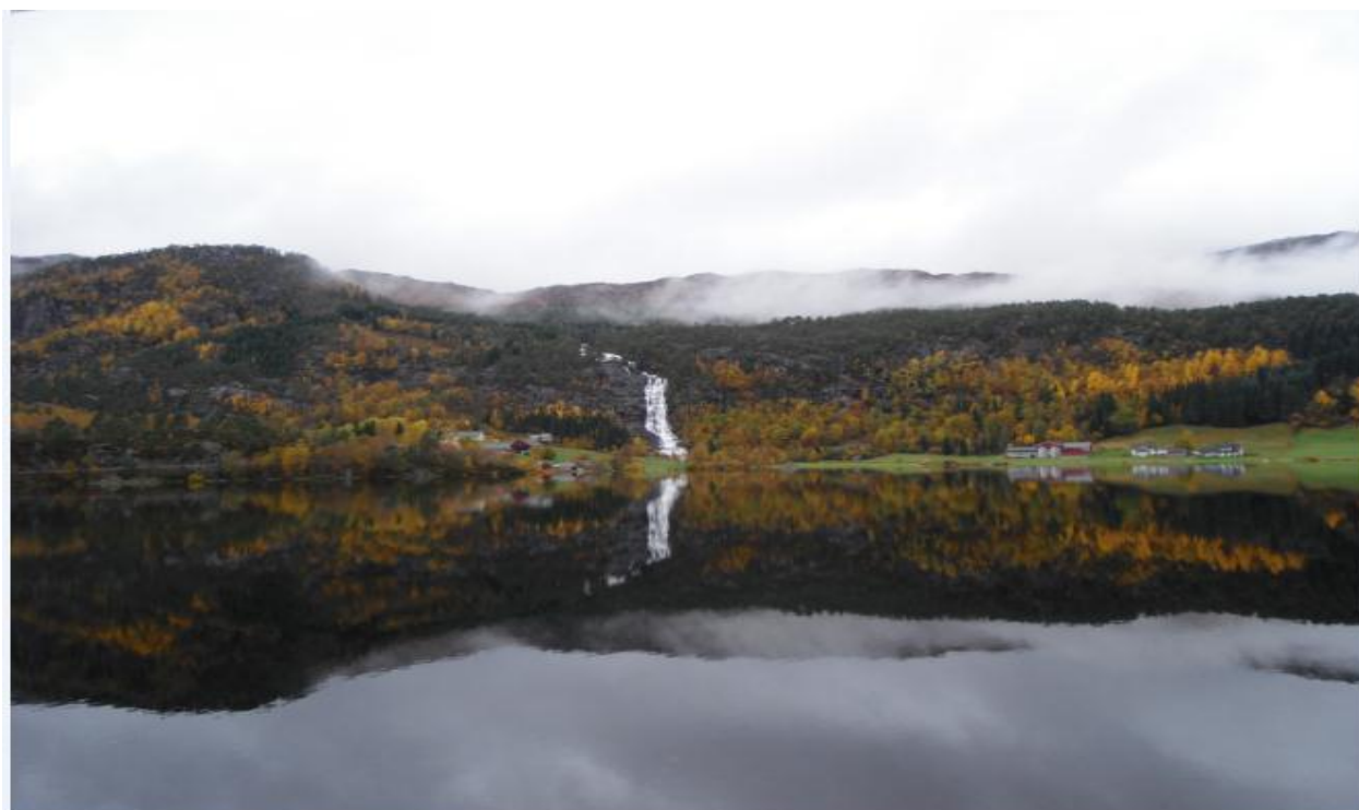
Løkkebø kraftverk sett fra motsatt side av Løkkjebøvatnet. Dato 18.10.2008 klokken 16.35. Anslått vannføring er 6000 l/s.
