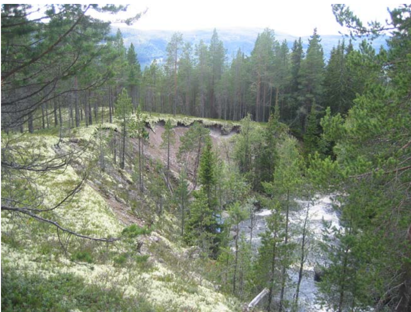
Bilde 8: Erodert skråning ved elva.
