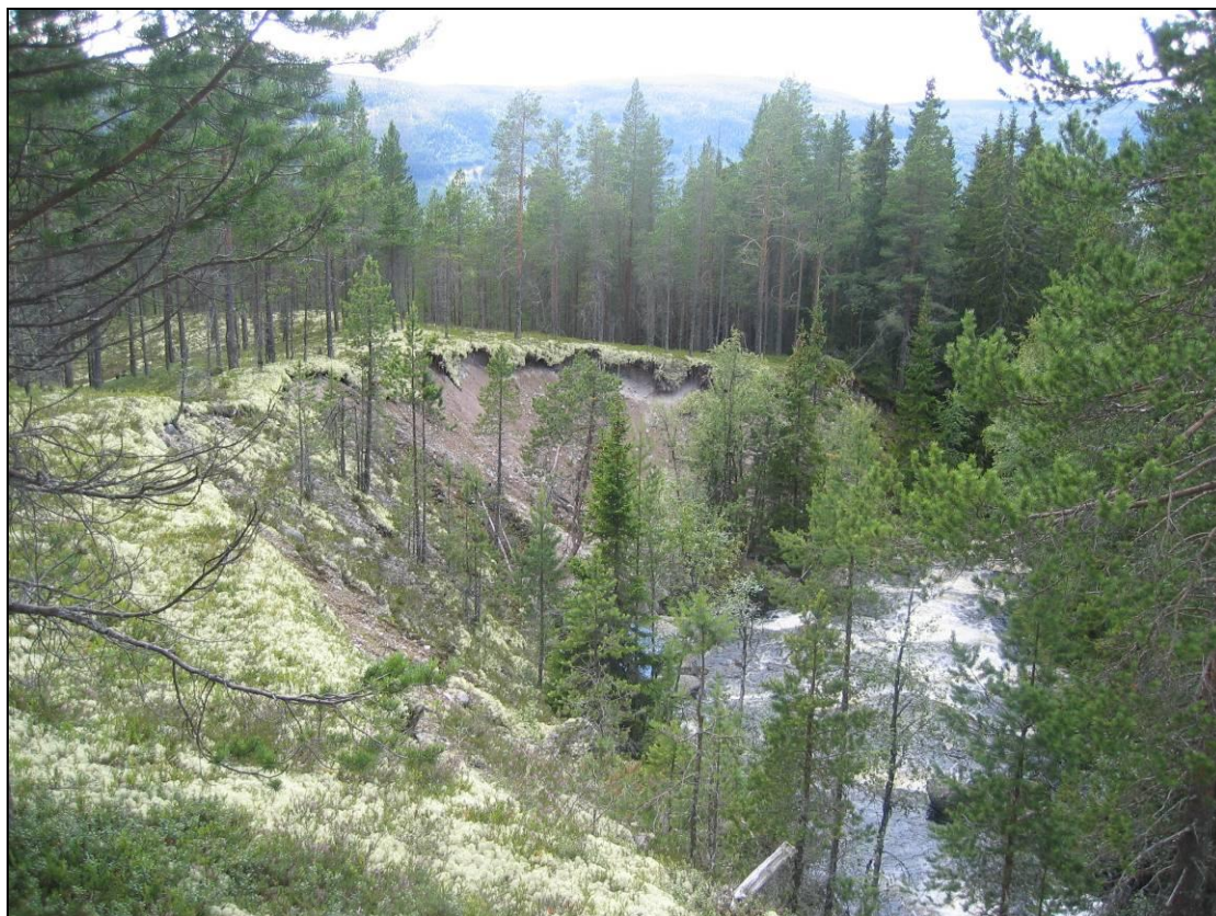
Figur 11. Skjæring rett oppstrøms den nedre bekkekløfta i Kverninga
