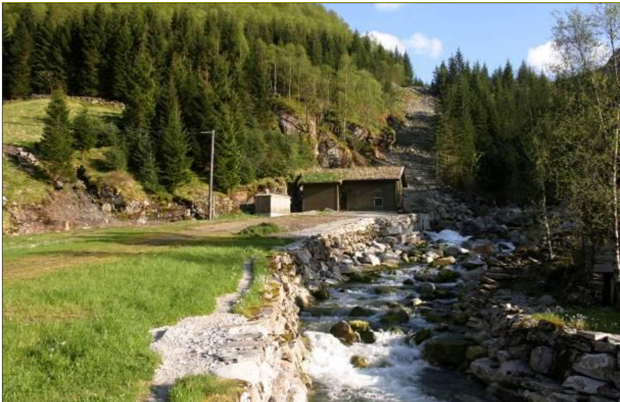
Figur 16. Eksempel på kraftstasjonsbygning med god arkitektonisk utforming og materialbruk tilpasset omgivelsene. Etter hvert som rørgatetraseen revegeteres vil synligheten av disse inngrepene være begrenset.
