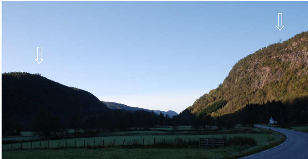
Fig 16-27b Austredalen sett fra nord. Ledningen vil krysse dalen tilsvarende eksisterende Statnettledning. Eksisterende "Statnettmaster" er vist med hvit pil på begge sider av dalen.(foto AEVK)
