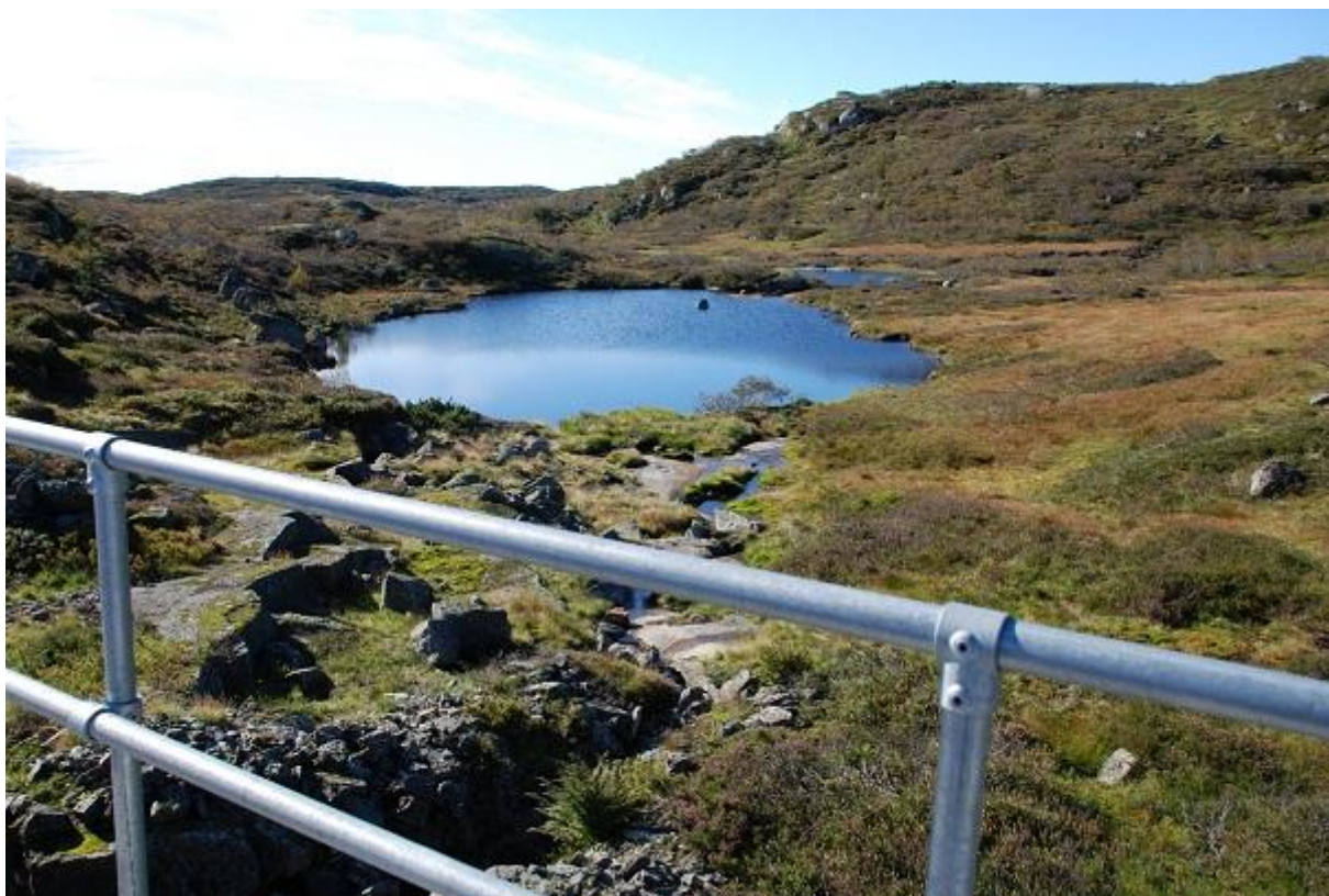
Bilde 5. Dam Øst nedstrøms
