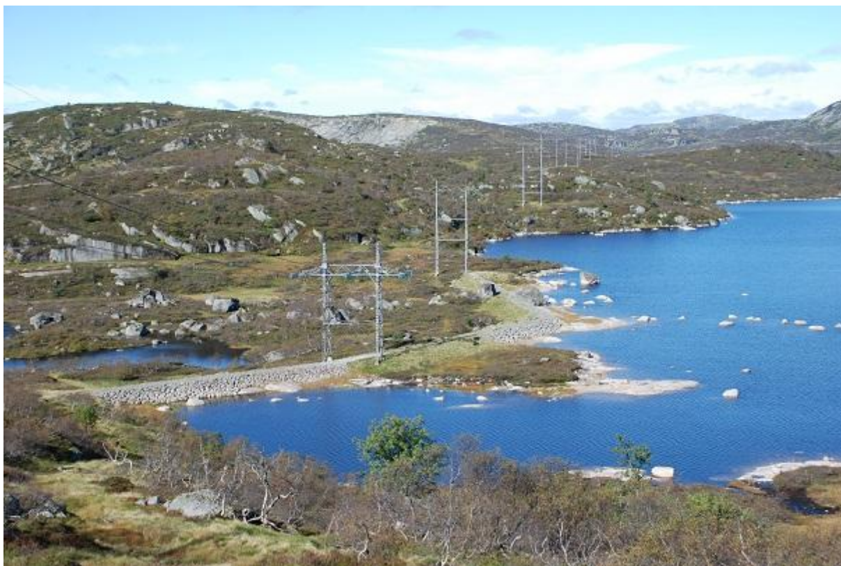
Bilde 7. Dam Midtre oversikt.
