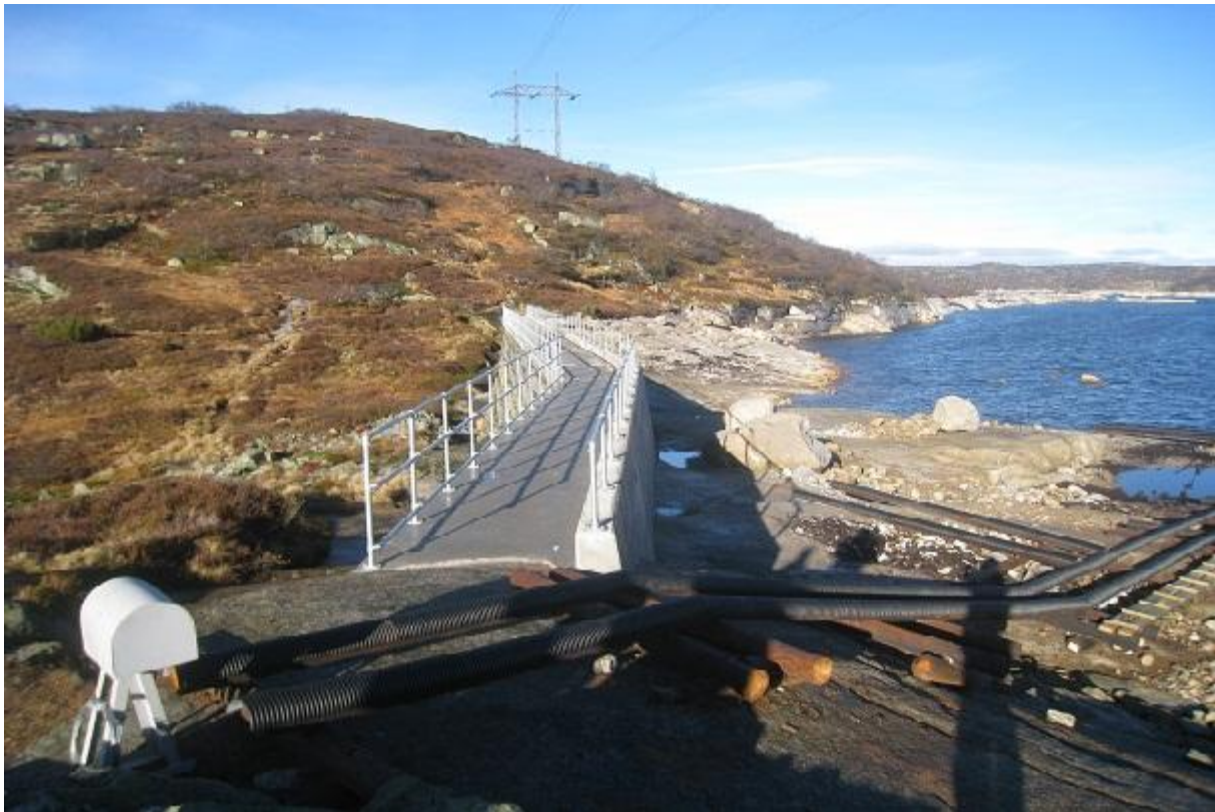
Nytt båtopptrekk i 2010 i Stegilvatn (dam øst)
