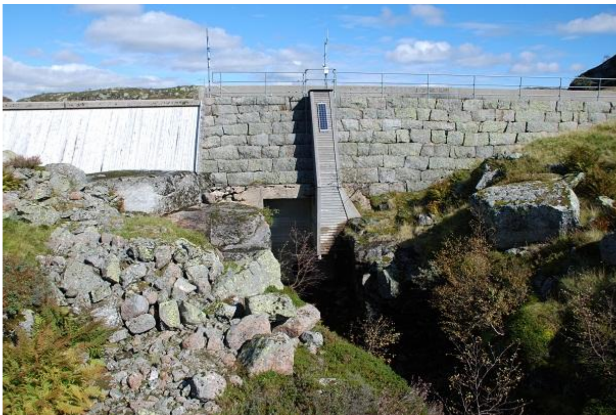
Bilde 9. Dam Vest luftside med tappeluke.
