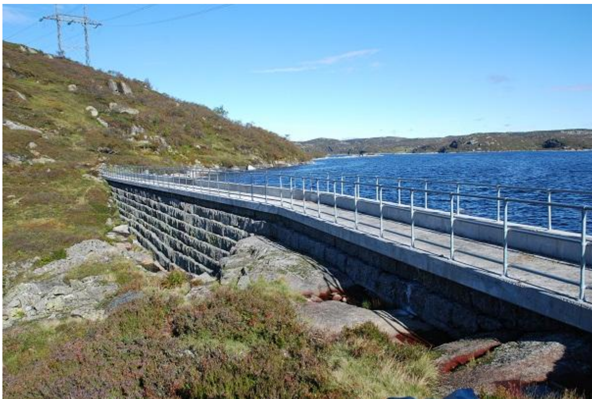
Bilde 4. Del av dam Øst luftside.
