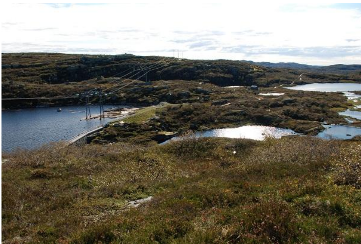
Bilde 6. Dam Øst oversikt (med Statnett sin mast 100 i magasinet).
