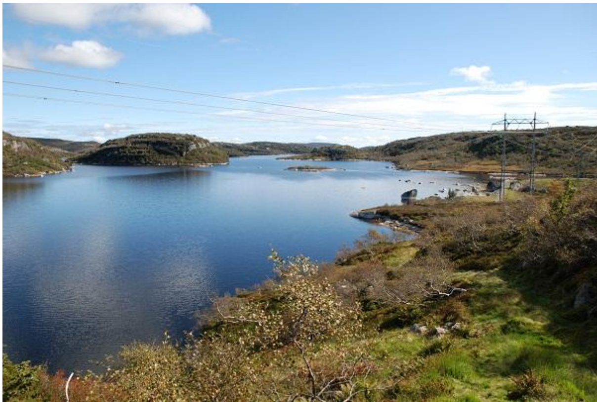
Bilde 1. Stegilvatn med dam øst til høyre i bildet.
