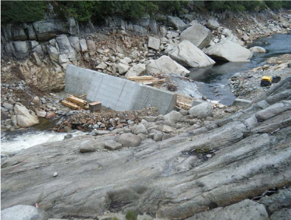
Figur 6 Terskelen under bygging
