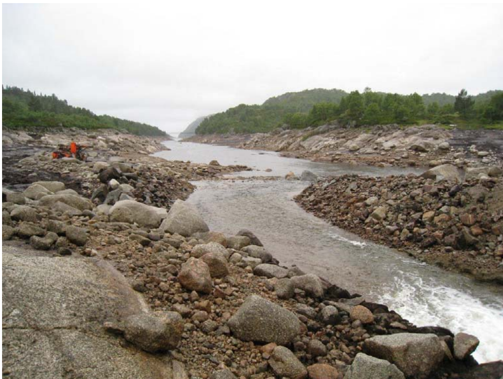
Figur 4 Utløpet av Åstølvatn (sett sydover) – etter kanalisering. Bildet er tatt før terskelen var ferdig, slik at vannstanden på bildet er godt under kote 621.
