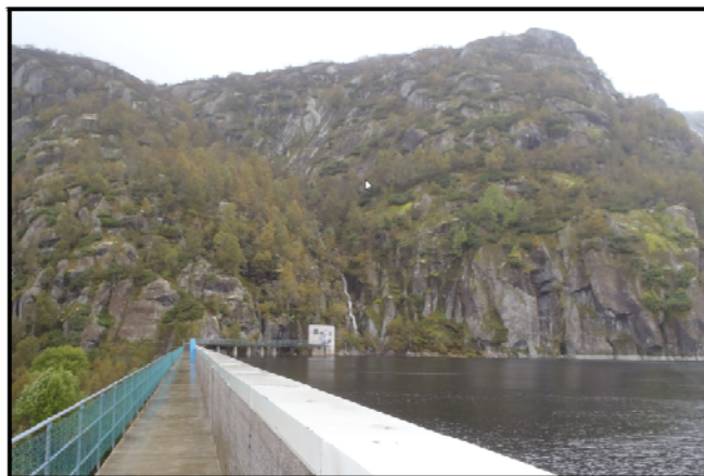
Figur 7-6 Langevatn med dam og deler av vestre bredd.
