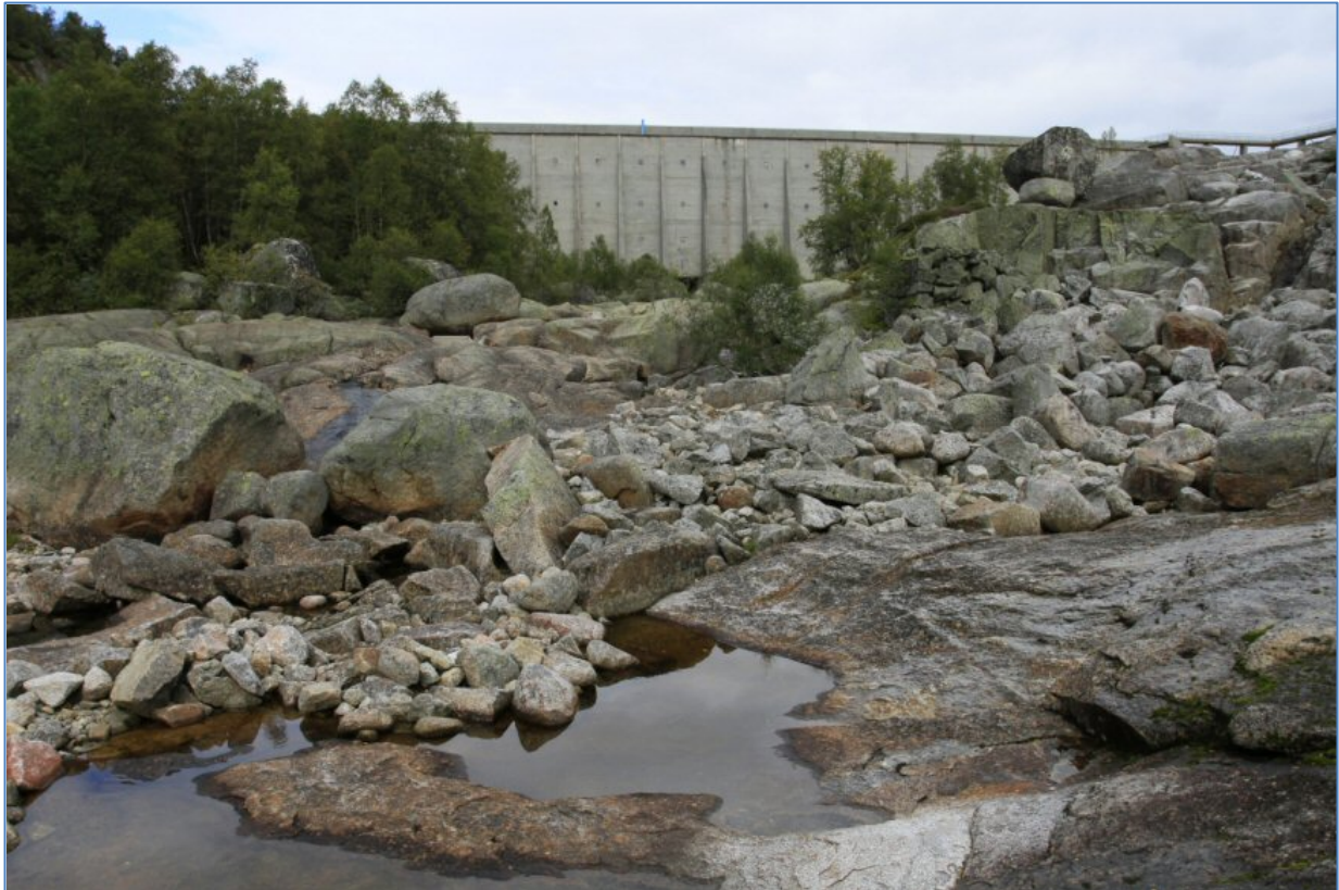
Figur 6-11. Dam Langevatn sett fra elva Monn like nedstrøms. Foto: F. Gravem, Sweco.
