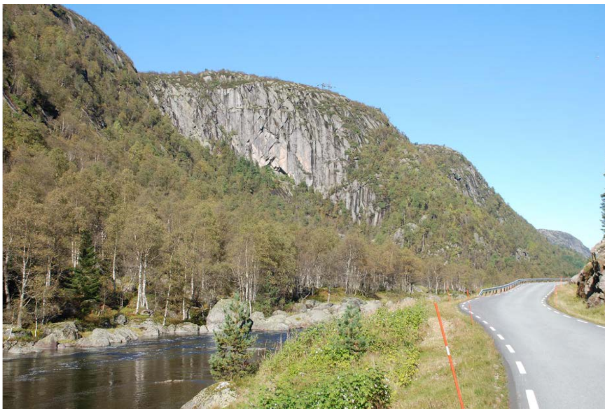
Figur 7-9. Vestredalen og kryssing av Monn sett fra sør. Dagens situasjon. Foto: AEP.
