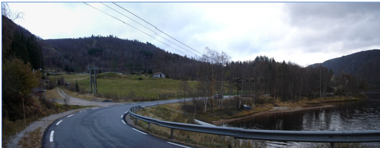
Figur 7-7. Området ved Kløystøl, hvor alt. 2.0 er tenkt ført fra kabel i vann til luftledning. Sett fra nord mot sør. Panoramabilde. Foto. I. Bjørnstad, Sweco.
