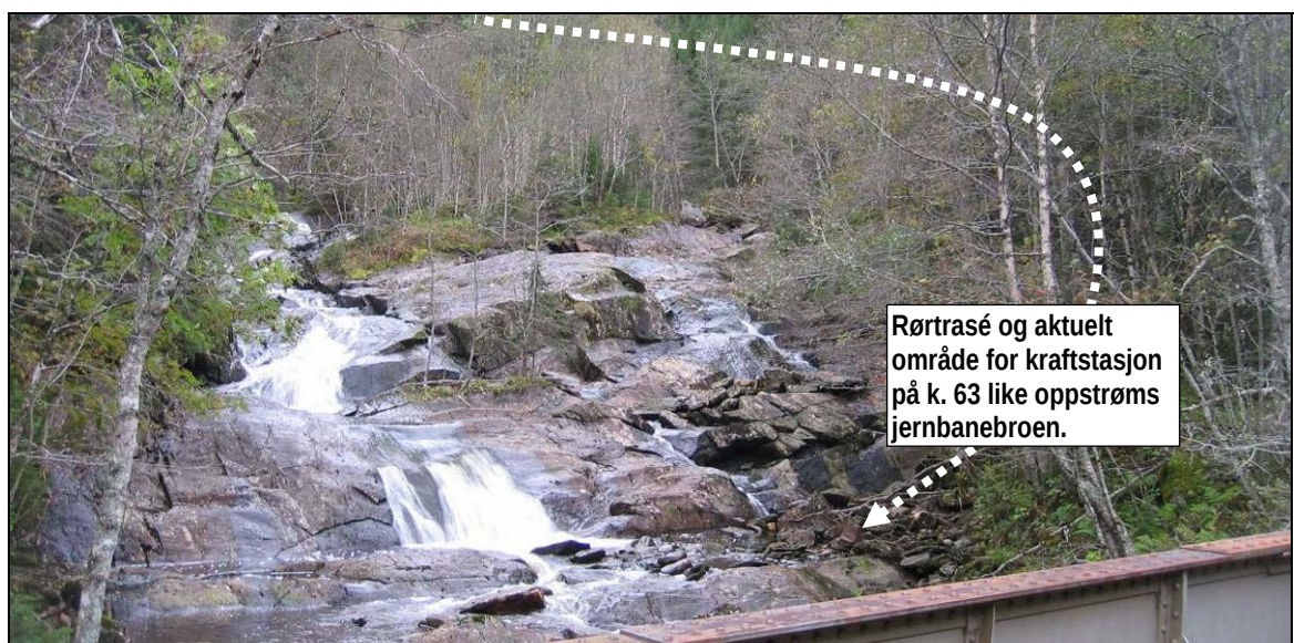
Figur 10 Rørtrasé og aktuelt område for etablering av kraftstasjon på kote 63 sett fra jernbanebroen.
