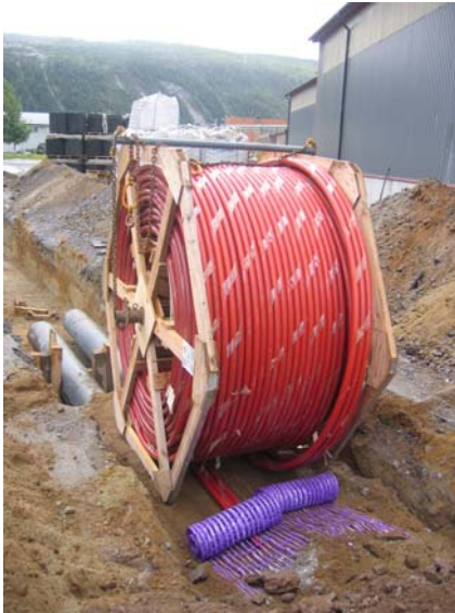
Figur 6 Sammen med fjernvarmerørerne legges 3 trekkerør. Markeringsbånd merker hvor fjernvarmerørerne ligger.
