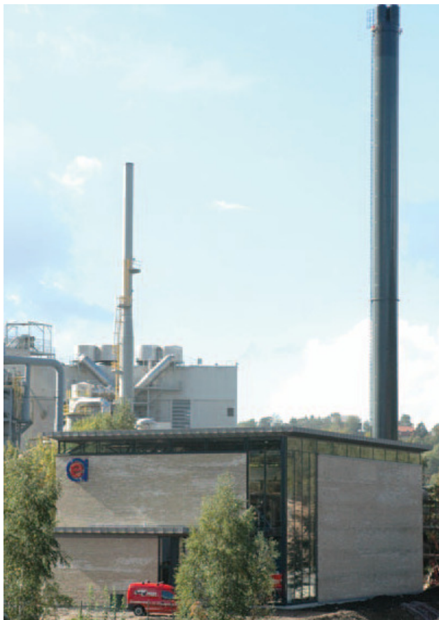
Figur 3 Bildet viser eksempel på rektangulær varmesentral (kilde: Agder Energi Varme, Vesterveien Energisentral Kristiansand (32 MW oljekjeler og 10 MW spillvarme)).
