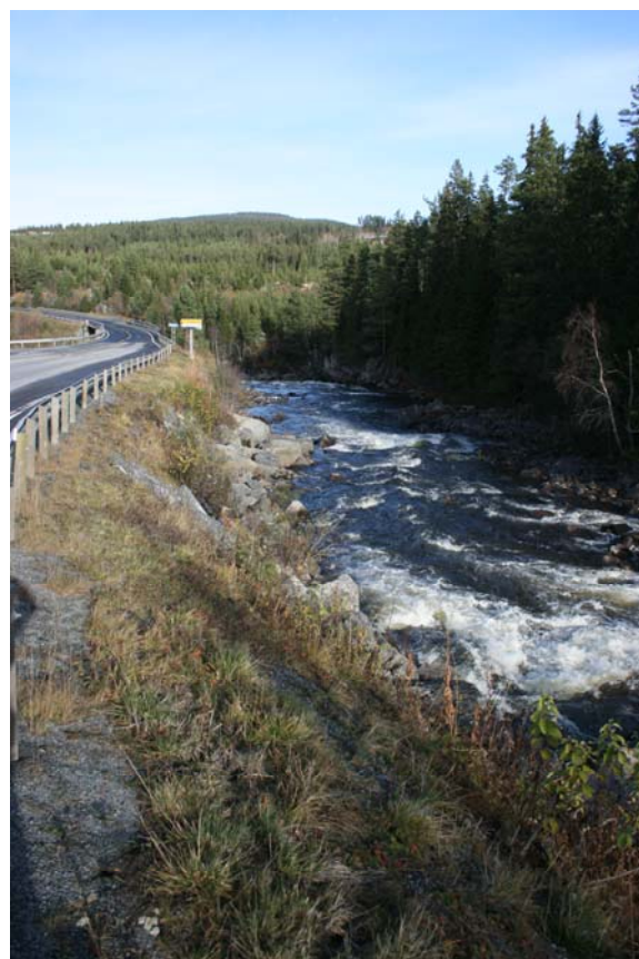
Bilde 3.6 Elva ca kote 360 moh & ned
