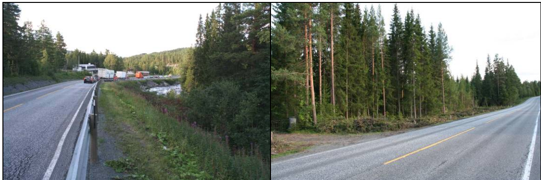
Figur 15. Nedgravd rørgate vil over mesteparten av strekningen legges i veiskulderen langs E6 (fotos 14. august 2007: Ole Kristian Spikkeland).
