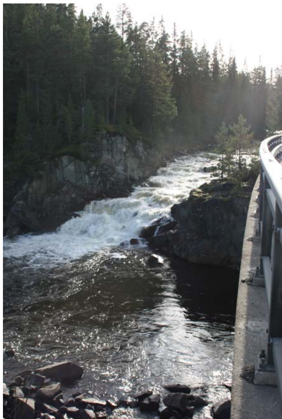
Bilde 1.3 Fra Kløftbrua 9. Okt. 2007
