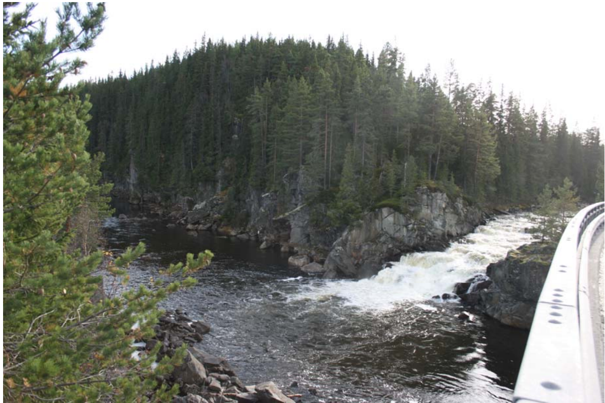
Bilde 5.2 Blir sprengt inn i fjellet midt på bildet
