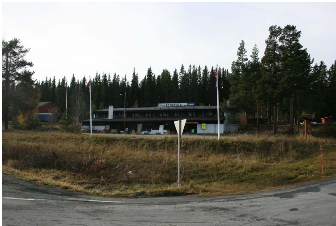
Bilde 4.1 Eksisterende 22 kV nett er i skogen bak Motellet
