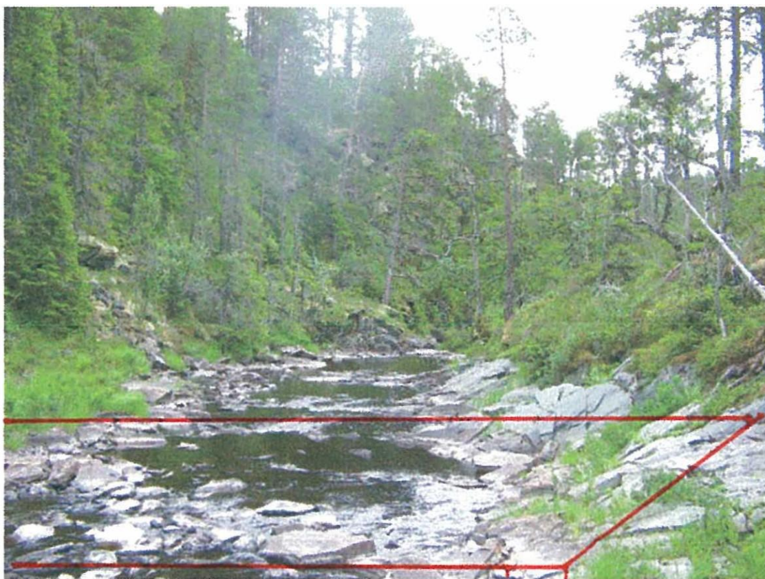
Figur 1: Dam anlegges i forkant bilde.
