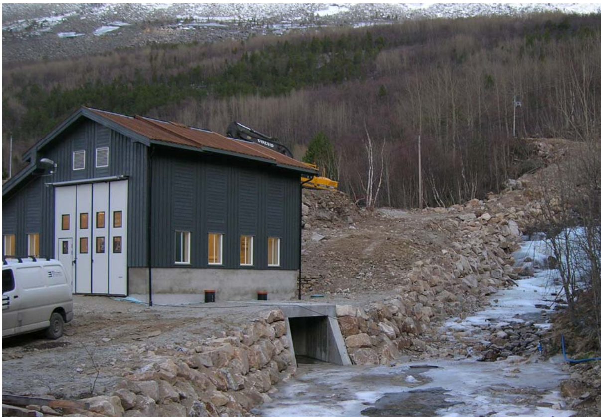
Bilde 05 Kraftstasjonen på Lappvikelva kraftverk
