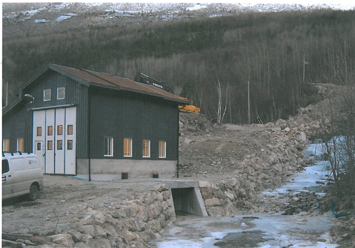
Bilde 05 Kraftstasjonen på Lappvikelva kraftverk
