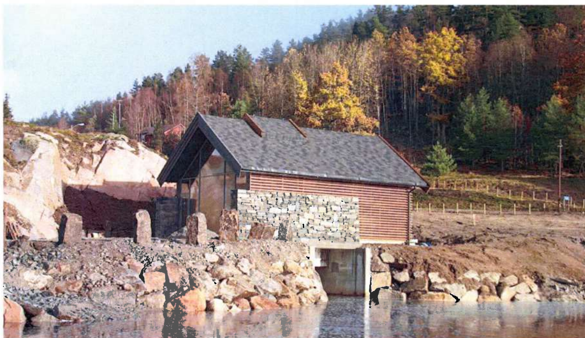
Eksempel på kraftstasjonsutforming, Oftedal I kraftverk.
