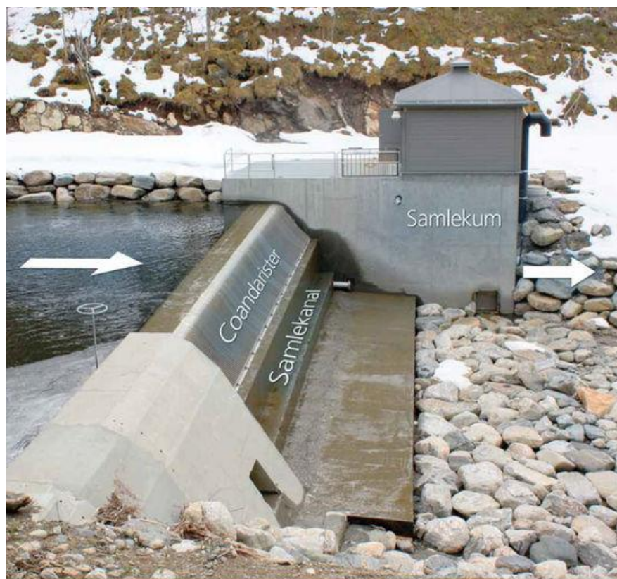
Fig 8: Eksempel på Coanda-inntak. Dette eksemplet er henta frå eit noko større anlegg enn Eldeelva.
