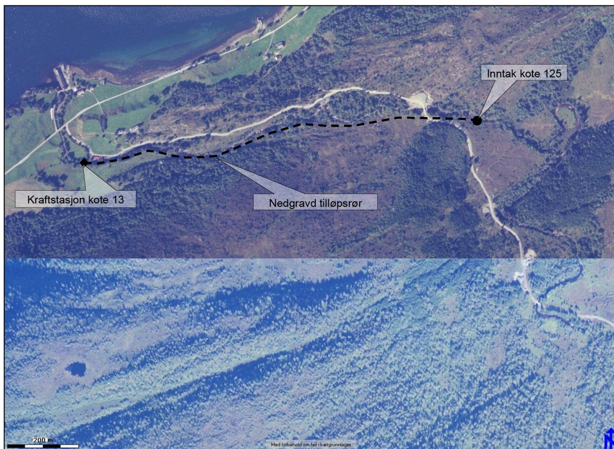
Fig 3: Oversiktsbildet frå Nordfjord i bilder, syner dagens situasjon med noverande inngrep. Planlagt inntak, kraftstasjonsplassering og røytrase er avmerka.
