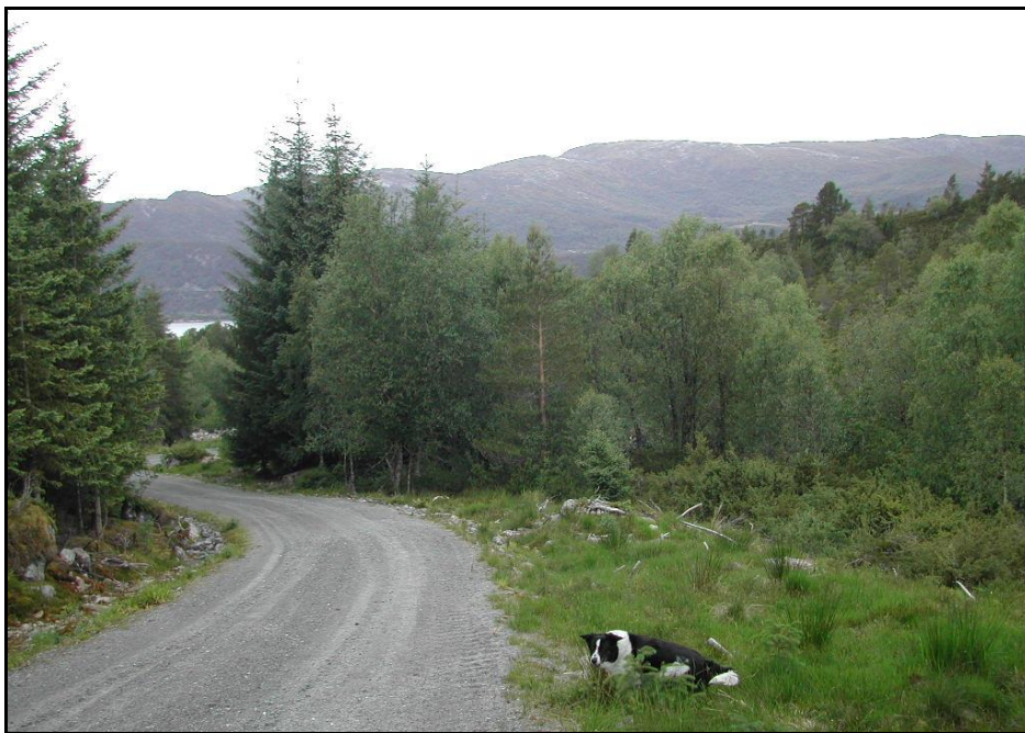
Fig 10: Bildet viser stølsvegen eit stykke nedstrøms inntaket.
