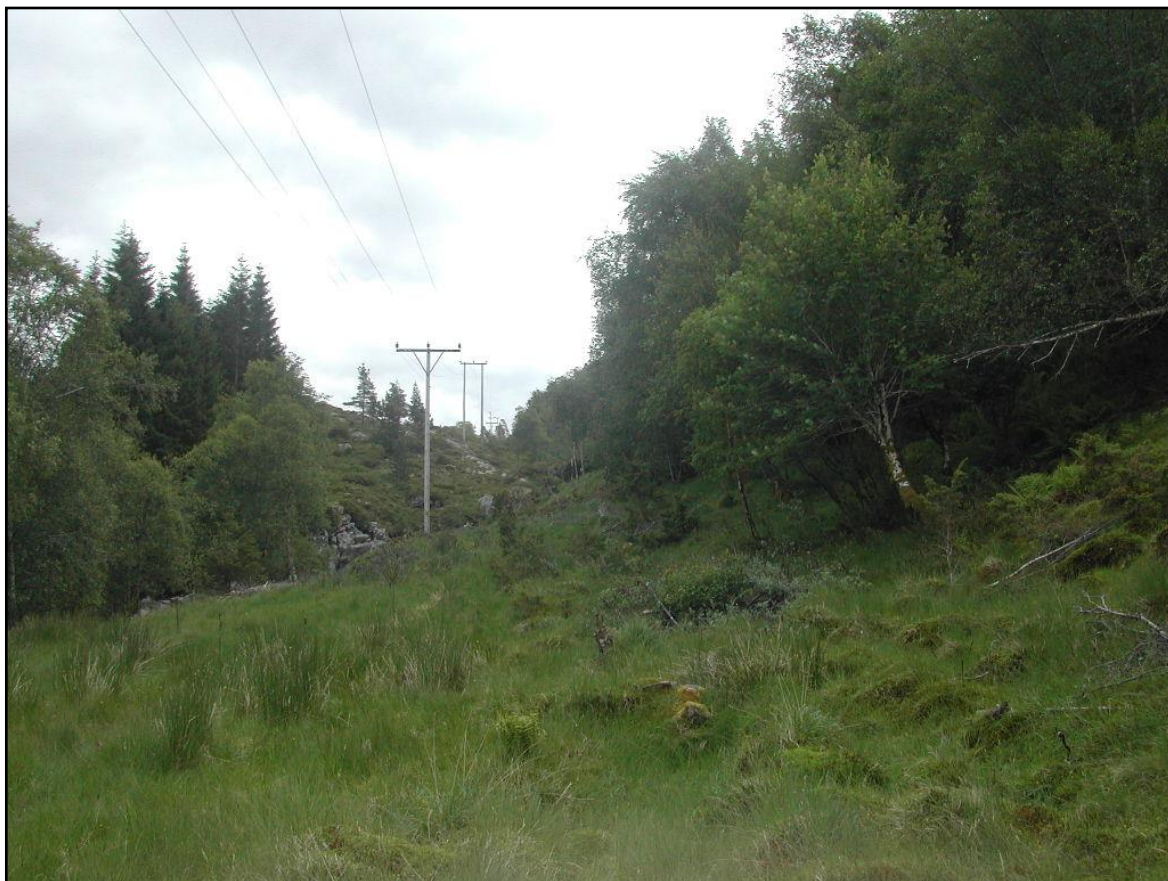
Fig 12: Bildet viser nedre del av rørtraseèn, eit stykke ovanfor kraftstasjonen.
