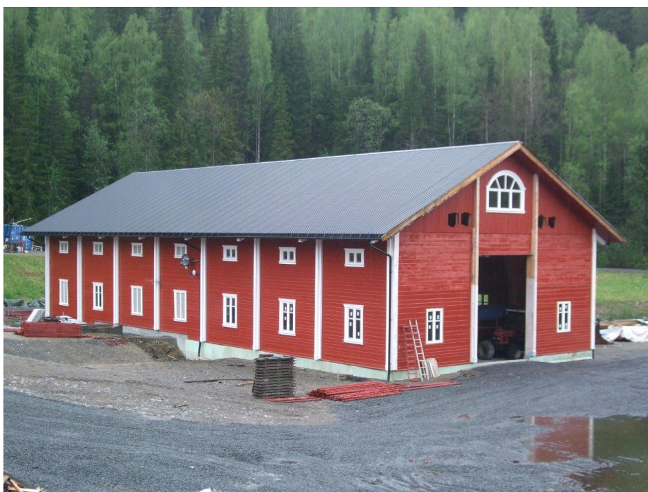
Figur 19: Veslefallet Kraftverk, prinsipp for kraftstasjon for Litflåttådalselva Kraftverk. Stasjonen er oppført på betong med limtrebuer og slippluft, samt heltretak med plater. De 3 seksjonene til høyre i bildet er redskapshus som benytter overskuddsvarme fra kraftstasjonen til oppvarming.
