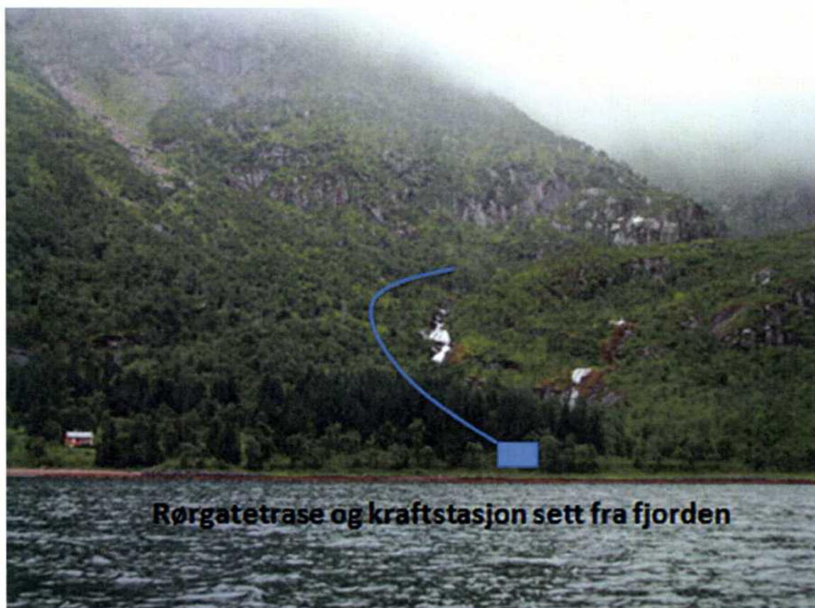
Rørgatetrase og kraftstasjon sett fra fjorden
