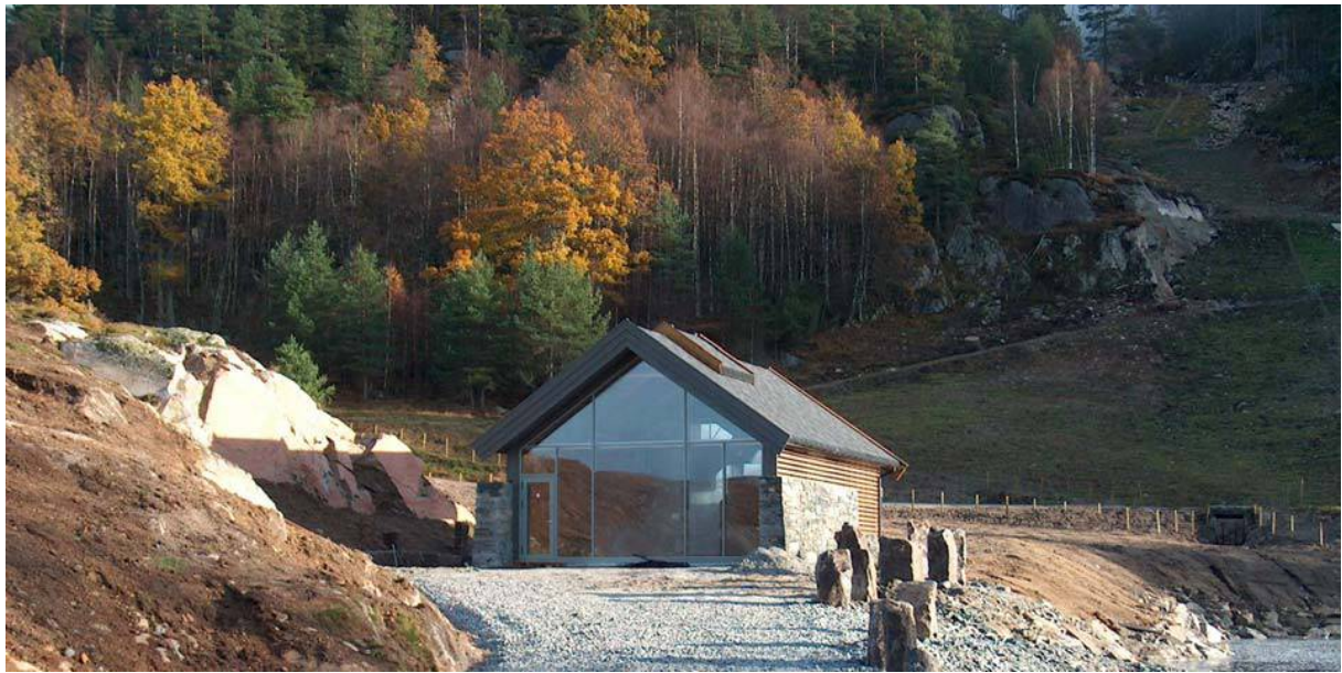
Eksempel på kraftstasjonsutforming, Oftedal I kraftverk.
