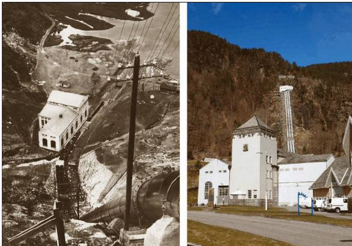
Figur 3. Frøland kraftverk i 1912 (til venstre) og i 2008 (til høyre). Foto: BKK, fra meldingen.
