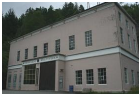
Figur 29. Grønsdal kraftstasjon er et landemerke ved Grønsdalsvatnet.
