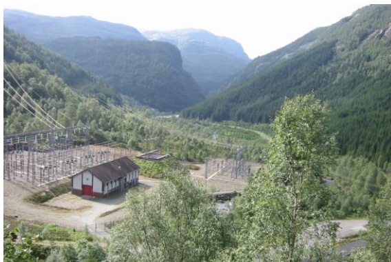
Figur 52. Trafostasjon og kraftlinjer dominerer landskapet i dalbunnen.
