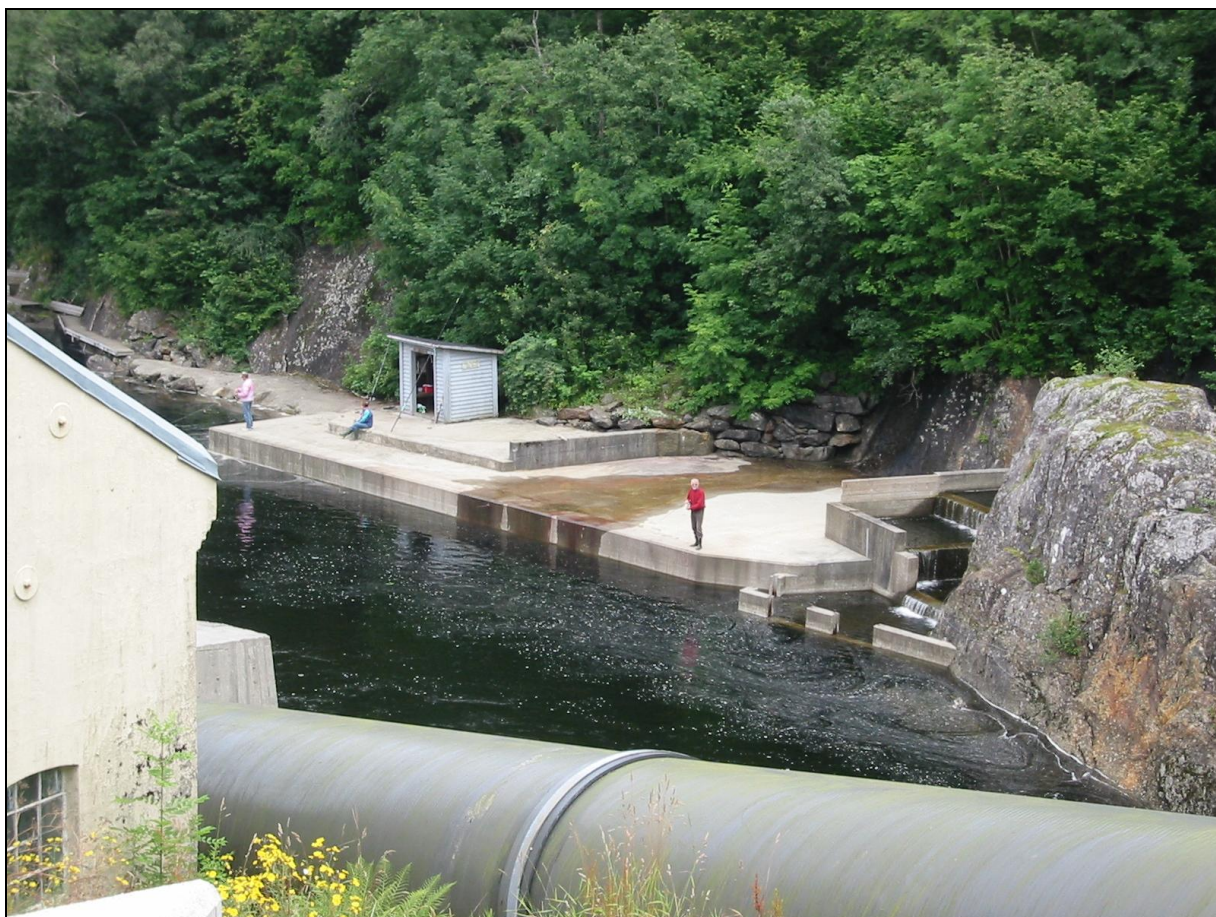
Figur 20. Fiskere på tilrettelagt fiskeplass ved utløpet av Tysseelva. I forgrunnen sees rørgaten til Tysse kraftverk.
