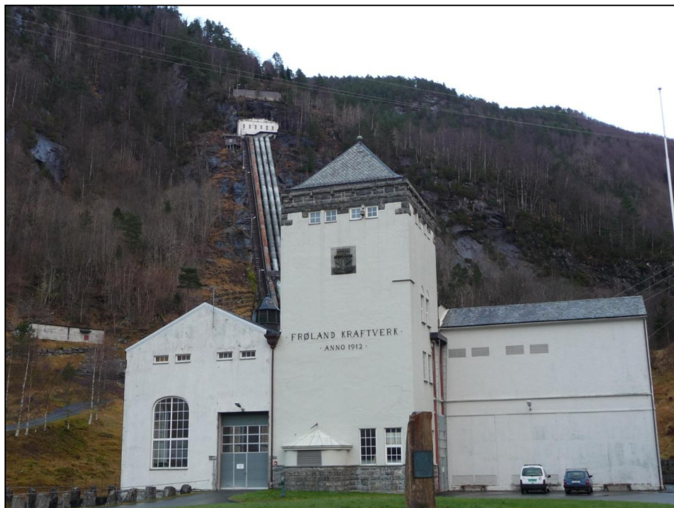
Frøland kraftstasjon stod ferdig i 1912.
