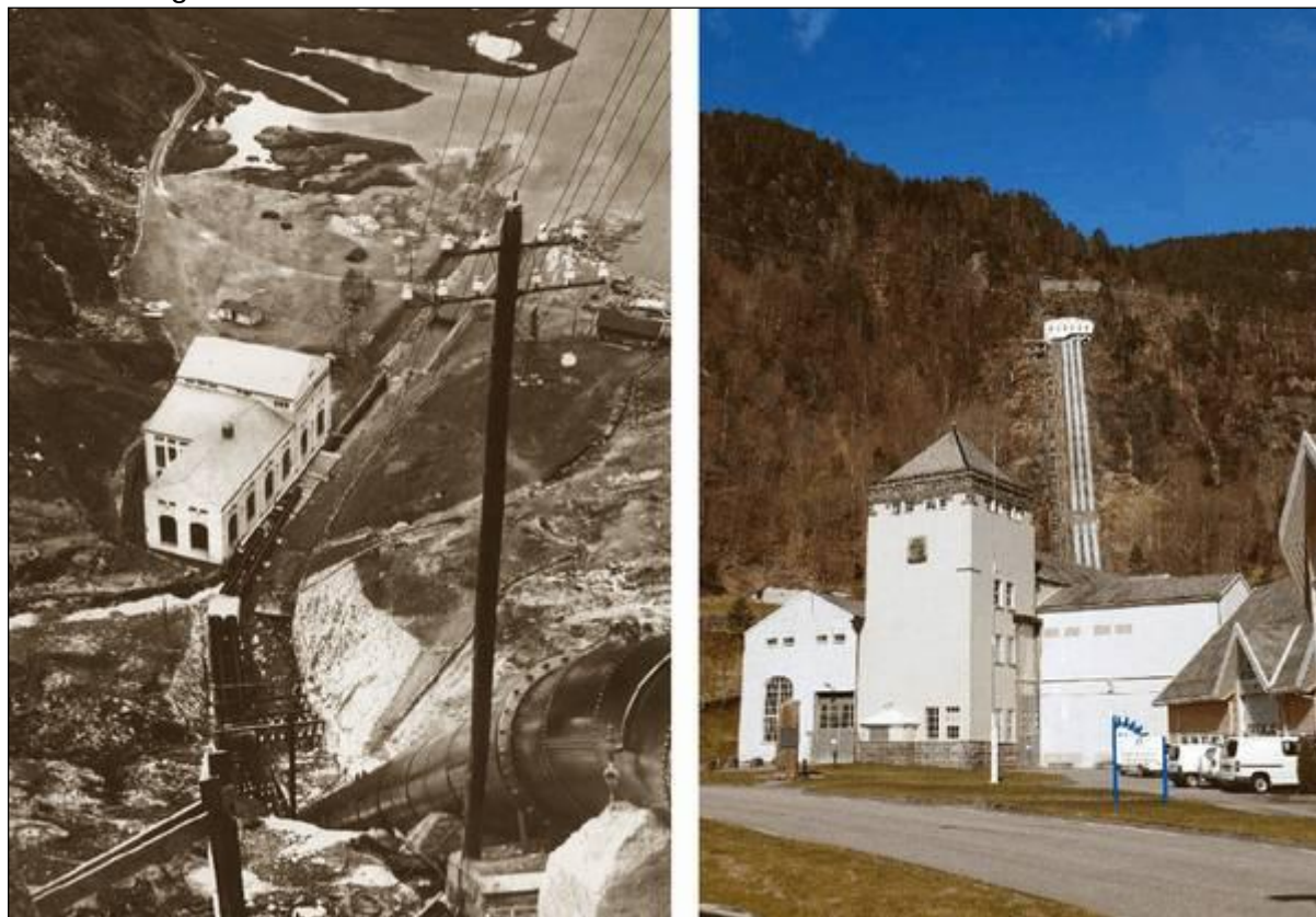
Frøland kraftverk i 1912 (til venstre) og i 2008 (til høyre). Foto: BKK, fra meldingen.
