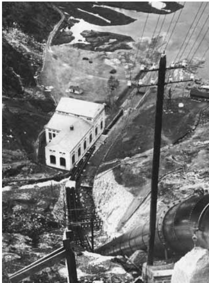
Frå bygginga av Frøland kraftverk i 1912. Kraftverket stod ferdig 1921.
