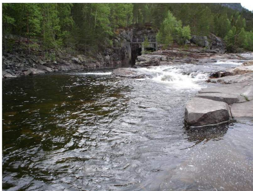
Foto fra samløpet ved utløpet fra kraftstasjonen.
