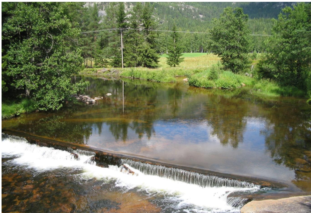
Bilde 7. Midt på strekningen mellom Gjevden og utløp Jørundland.
