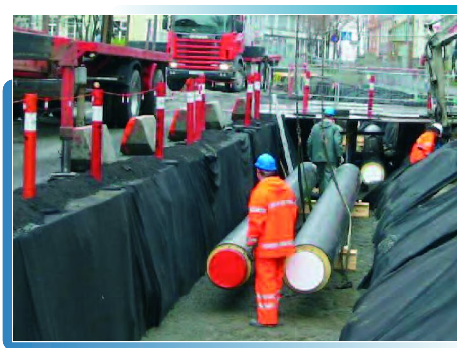
Legging av fjernvarmerør i Trondheim
