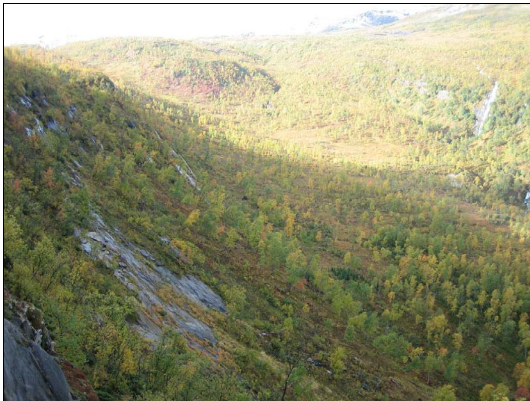
Foto 15. Foto viser dalen på nordvestsiden av Klumpen, hvor vannveien legges i rør mellom tunnelen og kraftstasjonen.
