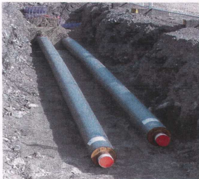
Figur 4-2, Fjernvarmerør fra bygging
