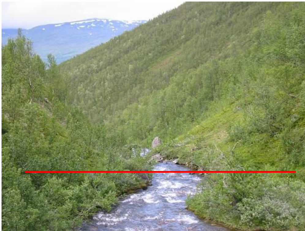
Bilde 2: Inntak på kote 318. Damkrone ved rød strek. Foto: Elvekraft
